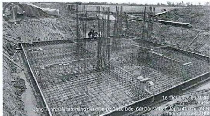
Dự án nâng tiết diện đường dây 110kV trạm 220kV Châu Độc – Cái Dầu
