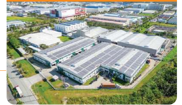
Dự án Hệ thống điện mặt trời áp mái Nhà xưởng Lô T4
