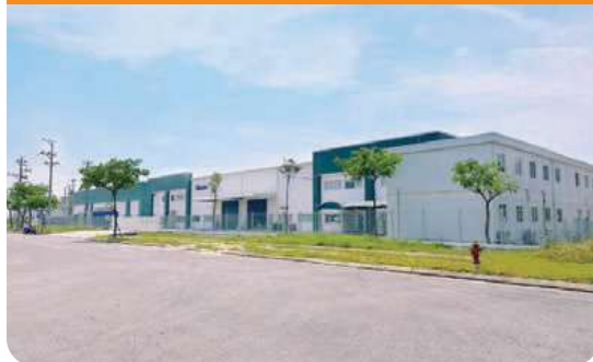
Nhà xưởng J4 - Giai đoạn 1 mở rộng tại Khu CNC Đà Nẵng
