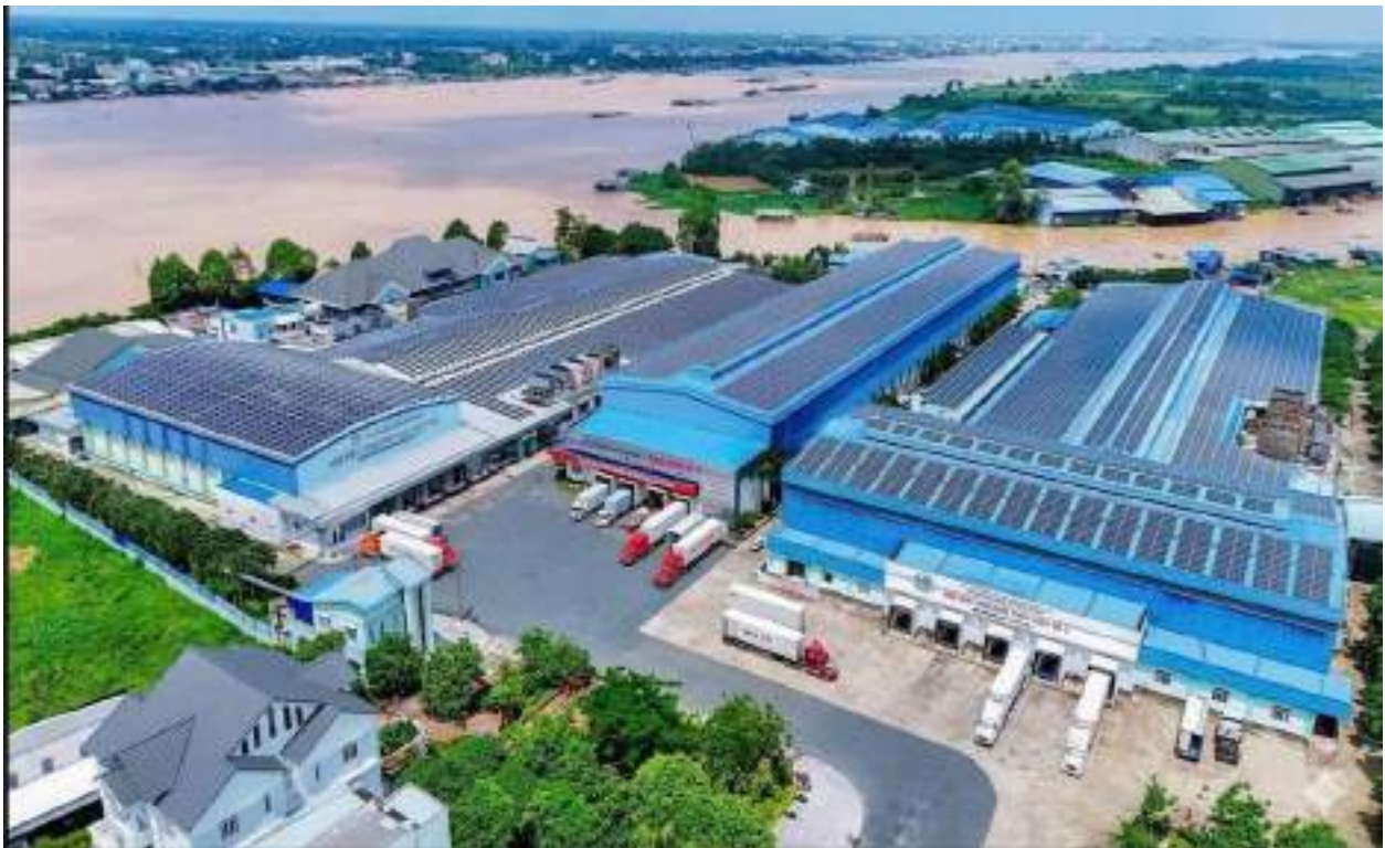
Hệ thống điện năng lượng mặt trời trên nóc nhà máy thủy sản I.D.I
