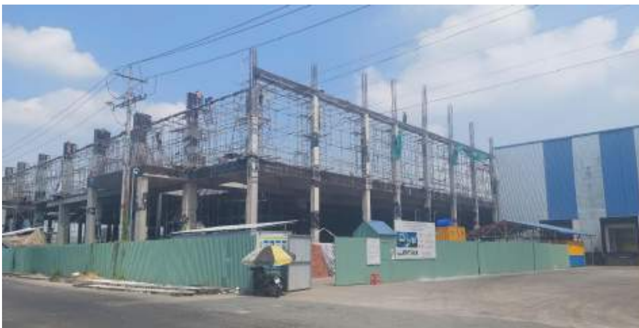
Nhà máy chế biến thủy sản Hoa Kỳ (Nhà máy số 03) đang xây dựng
